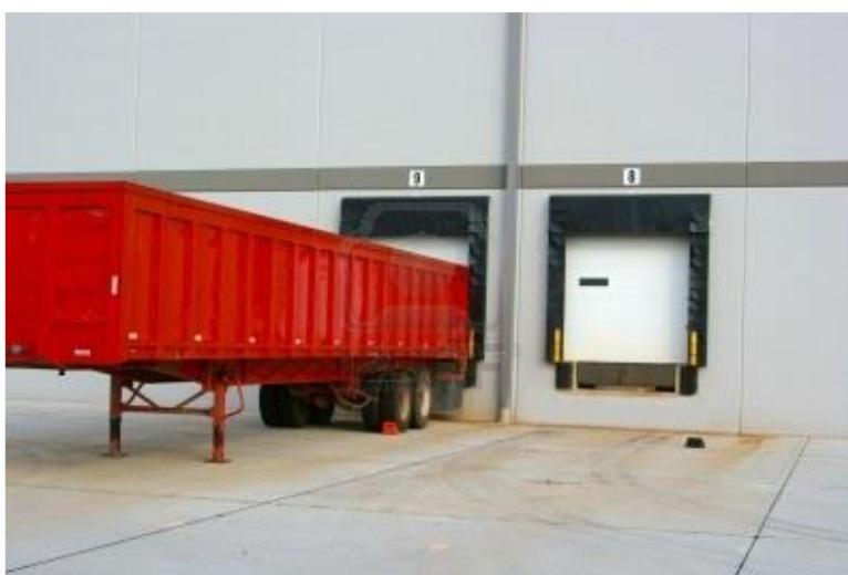
Figura 10. Posición de puerta de muelle.
