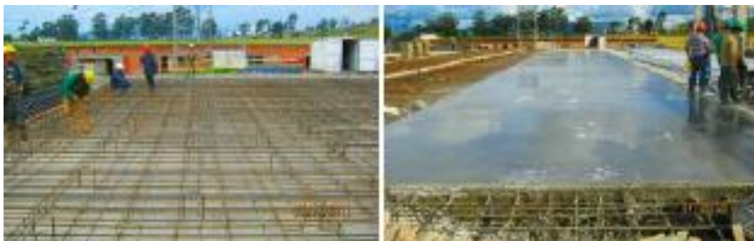
Figura 3. Imagen de acomodo de suelo en un terreno para un CEDIS (Restrepo, 2012).
