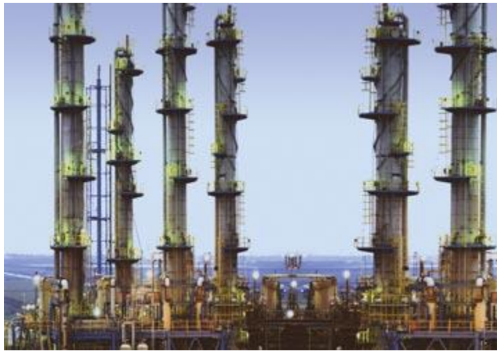
Figura 14. Torres de Destilación (Corporate Headquarters, USA, 2013).
