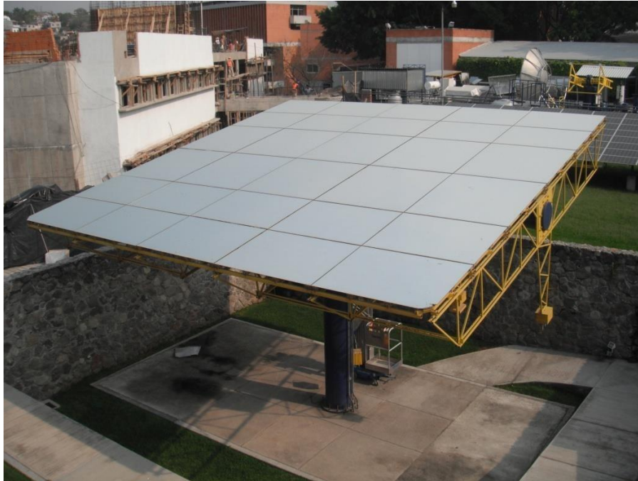
Heliostato instalado en el IER-UNAM.
