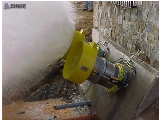
Figura 37. Válvula de cono fijo en operación.
