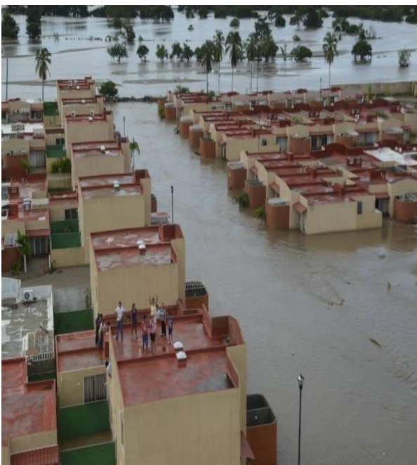
Figura 5. Inundación en Acapulco después del paso del Huracán Ingrid y de la tormenta tropical Manuel. Riojas, 2013.
