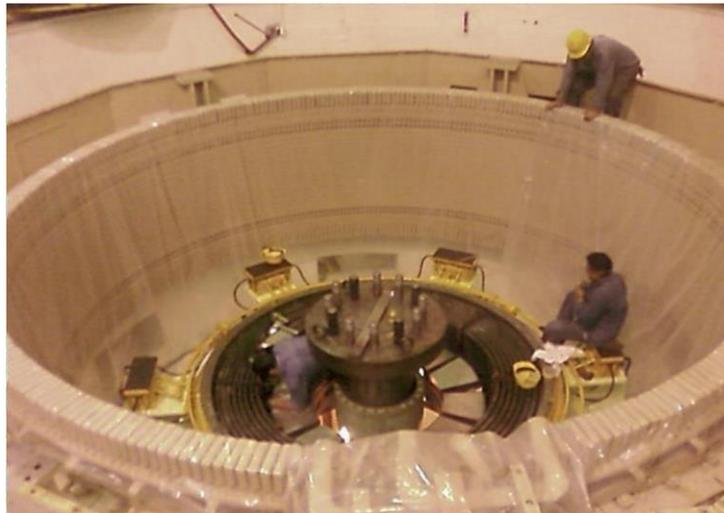
Figura 4. Estator de generador. Central Hidroeléctrica Manuel M. Diéguez. Foto tomada por Ing. Cesar M. López Andrade; bajo autorización del Jefe de casa de máquinas, (2012).
