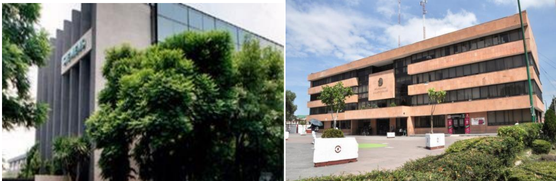
Sistemas fotovoltaicos interconectados a la red para uso comercial y de oficinas. Fuente: tomado de http://www.electronicosonline.com
